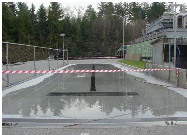
Le camion repasse dans un bain désinfectant avant de quitter l'enceinte de l'usine.
