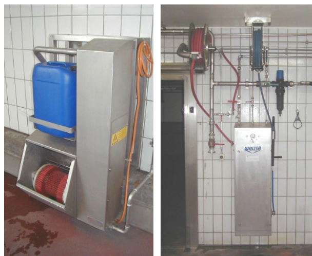
Les postes de nettoyage existants sont munis de désinfectants
