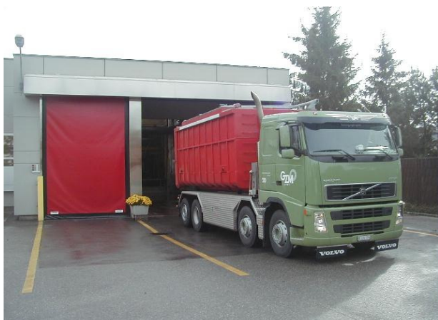
Halle de réception avec portes à déroulement rapide et dépression permanente.
